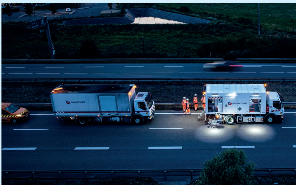
Chantier de signalisation horizontale sur l'A31 entre Champigneulle et Fey.
