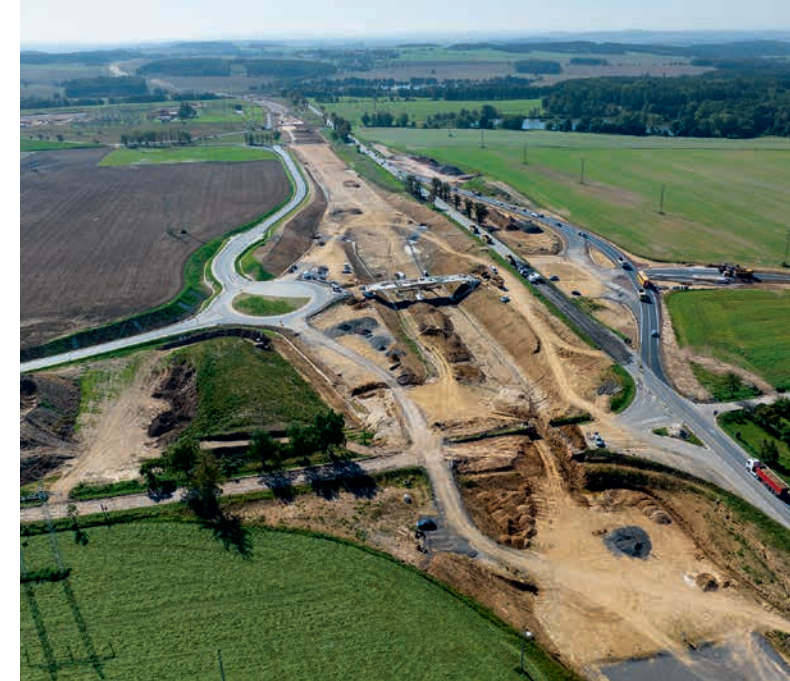
↑ Travaux de l'autoroute D4 dans le cadre du premier partenariat public-privé autoroutier en République tchèque.
